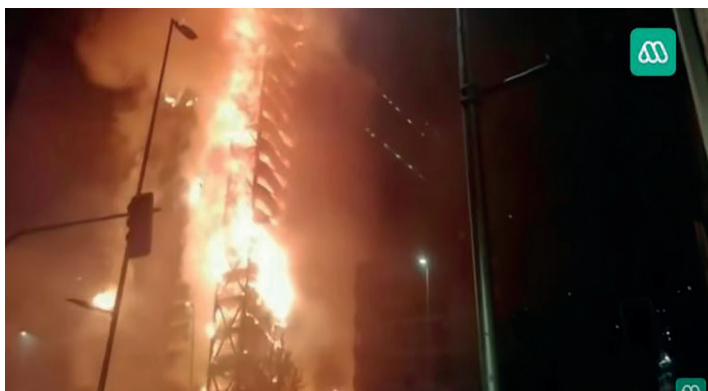
Figura 42. Caso 18: Incendio en el edificio ENEL
